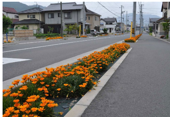
広島県 呉市 市道広古新開地内
