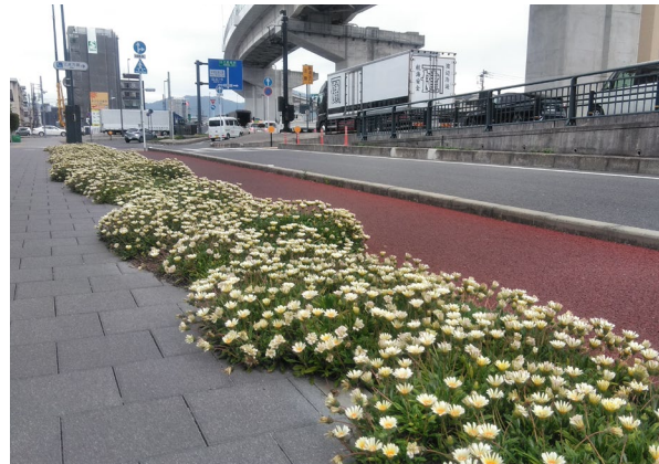
広島市 国道2号(広島高速3号線)
